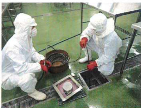
高圧洗浄状況
